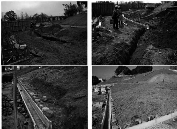
第82図 墳丘掘水路設置工
