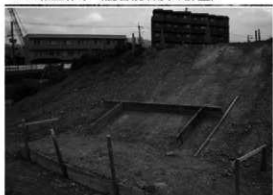
3 試験枠の設置
