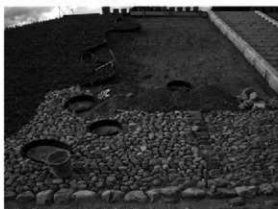
5 葦石積み上げ作業-1
