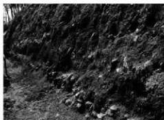
第48図 ジオファイバー基礎工 西壁面中世礫層
