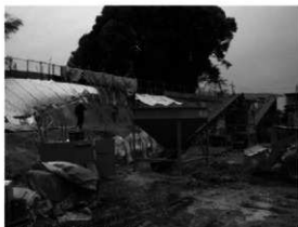
2 施工機械類設置状況
