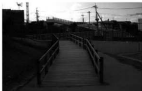
3 東木道スロープ (東から)
