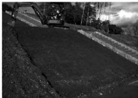
1 前方部前面葦石復元工掘削-1
