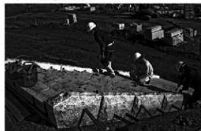
4 石階段取り付け工
