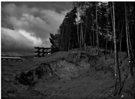
(1) 保存整備工事その1 B地区調査全景(南東から)
