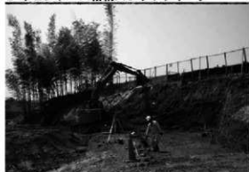
5 施工面成形掘削工
