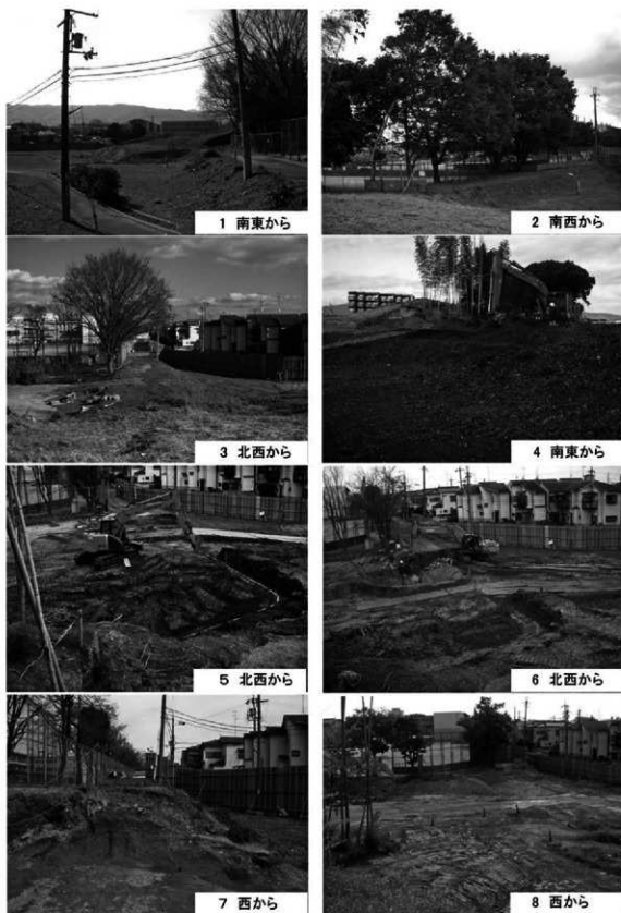
第81図 東堤撤去工
