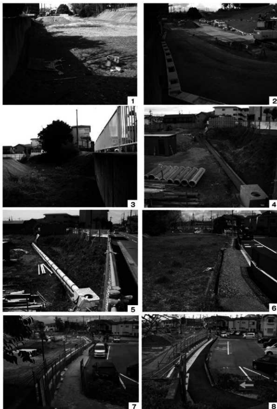
第83回 西辺・南辺排水路改修工
