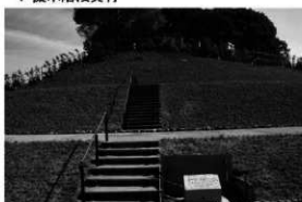
3 後円部西側設置の擬木階段
