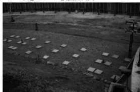
2 木道スロープ基礎設置 (南東から)
