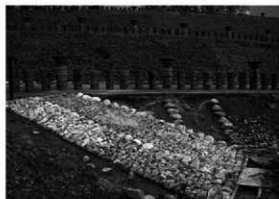
3 西くびれ部葦石復元工-2
