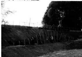
6 裏面排水施設設置工
