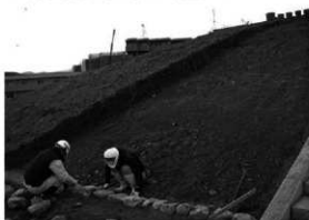
3 基底石配置作業
