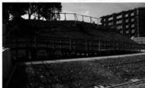
7 西木道スロープ設置状況 (北から)
