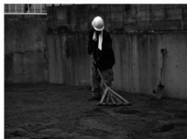
2 芝張り工 周濠南東隅部-2
