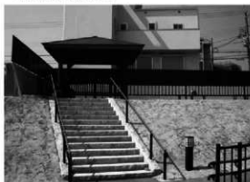
6 休憩広場、東屋完成状況
