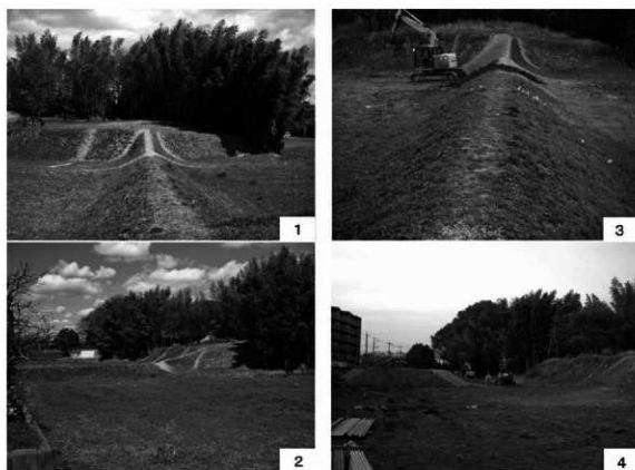
第80図 西堤撤去工 1・2 施工前 3着手 4撤去後 (1-西から、2-南から、3-南西から、4-南から)
