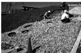
7 葦石積み上げ作業-3
