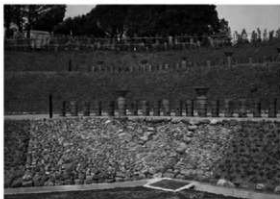
4 西くびれ部葦石復元工終了状況
