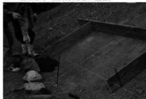
4 葦石復元（基礎石設置）
