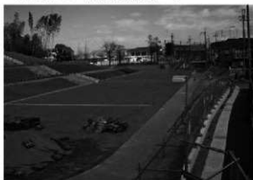
3 前方部前面周濠の芝張り前の整地状況
