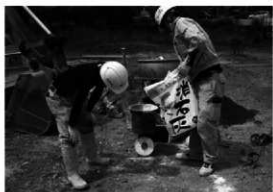
1 二和土作り（混合焼石灰の計量）
