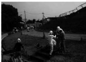
2 擬木階段設置工
