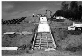
5 石階段コンクリート基礎工
