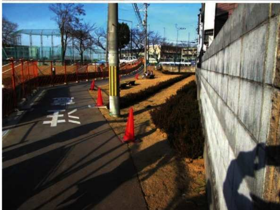
第209図 周濠南東隅の整備
