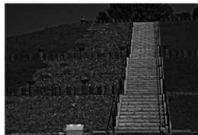
6 石階段完成状況
