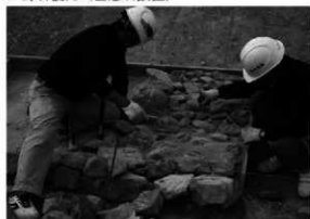
6 葦石復元（葦石敷き詰め作業）
