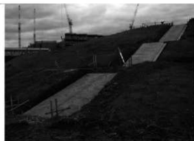
2 石階段裏面施工
