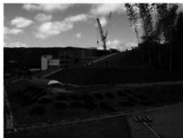
4 コクマザサ植栽工 (植栽土壌改良)
