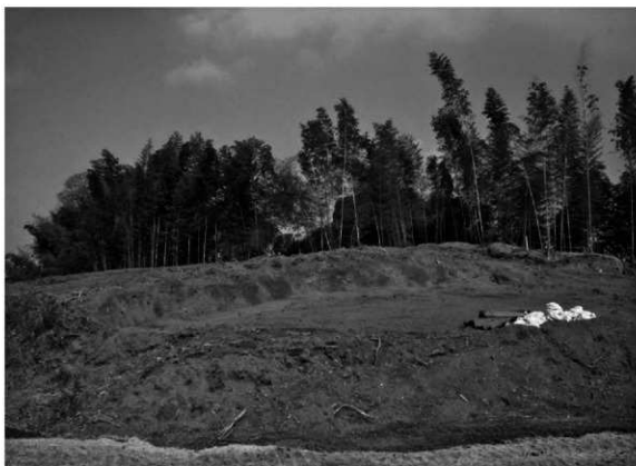
(2) 保存整備工事その1 C地区調査全景(南東から)
