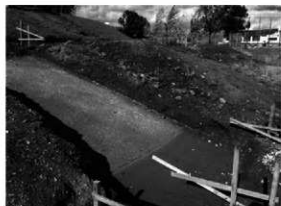
1 石階段基礎密削工
