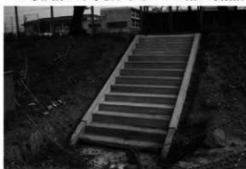
7 同上階段の整備状況
