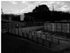
5 東木道スロープ設置状況 (南から)
