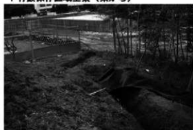
3 バンパーバリア埋め込み工
