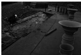
2 西くびれ部葦石復元工-1
