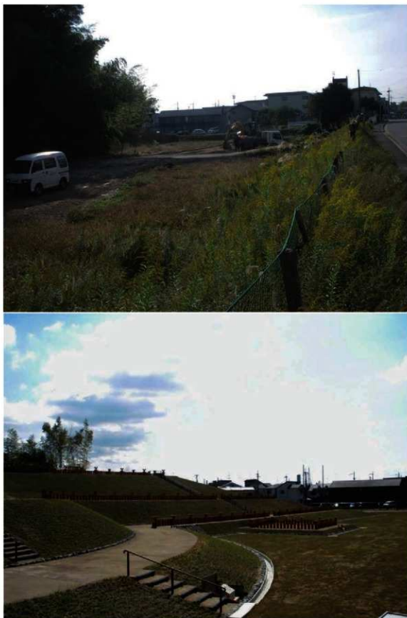
第203図 墳丘西辺の整備 上一整備前の景観（北西から）、下一整備状況（北西から）
