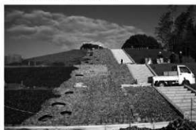
8 葦石積み上げ作業完了状況
