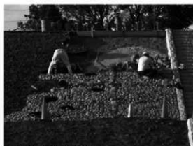
6 葦石積み上げ作業-2
