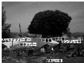
1 ジオファイバー施工風景（南東から）
