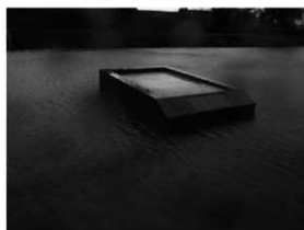
2 模型土台付近の貯水状況（南西から）
