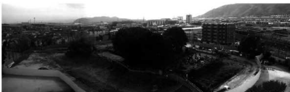
(3) 平成 24 年恵解山古墳保存整備工事その 2 竹樹木伐採状況全景 (北から)
