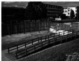
4 西木道スロープ設置状況 (南西から)
