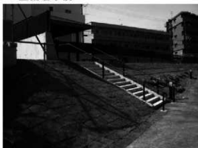
3 東屋、階段設置状況
