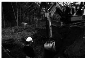
2 バンパーバリア埋め込み溝掘削工
