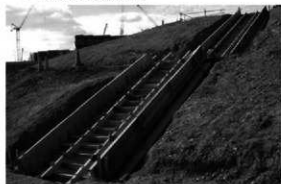
3 石階段コンクリート基礎工
