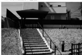
8 休憩広場昇降階段の整備状況
