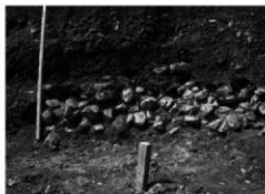
第49図 ジオファイバー基礎工 中世礫層の一部
