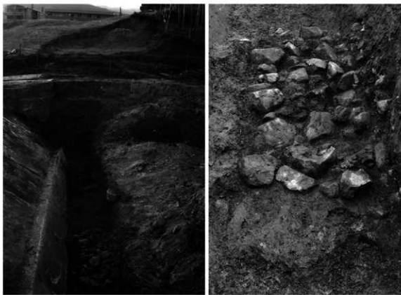
(1) 保存整備工事その2 L地区前方面東辺墳丘裾葺石検出状況(東から)
