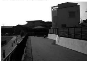
5 休憩広場完成状況
