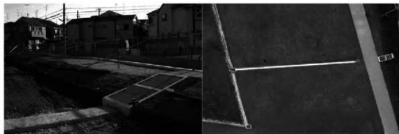
1 オリフィス設置状況（北西から）
