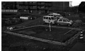
2 埴輪列基礎型枠
