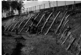
7 プレートアンカー設置工
