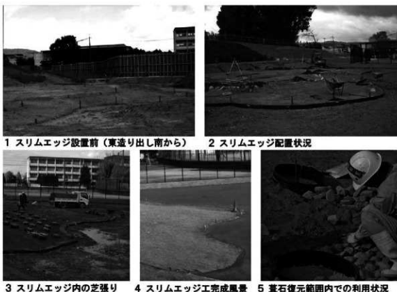
第96図 スリムエッジ設置工
