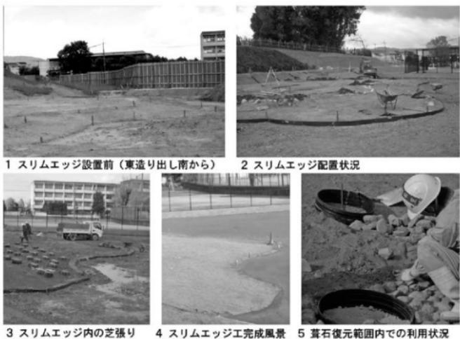
第96図 スリムエッジ設置工
