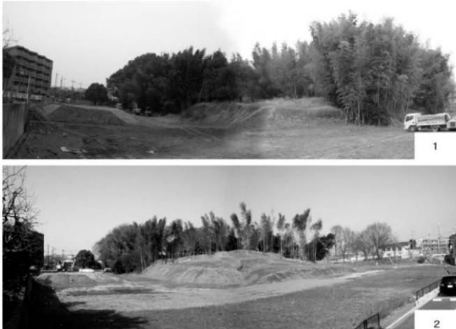
第78図 保存整備工事その1 前方部の竹木伐採除根工 1－施工前、2－施工後（南西から）
