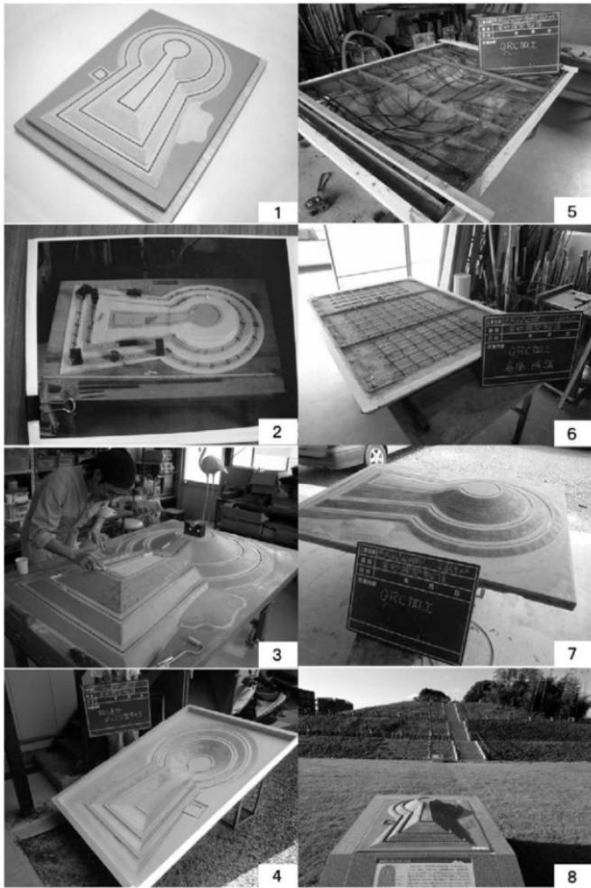
第72図 墳丘復元模型作製工程
