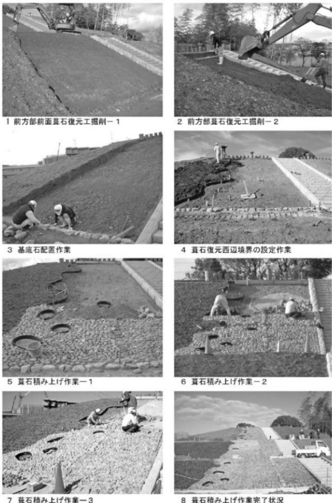
第102図 前方部前面の葺石復元工
