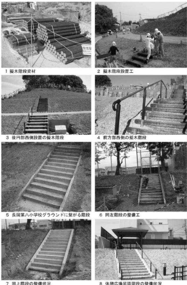
第150図 暫木階段、コンクリート階段・石階段の設置
