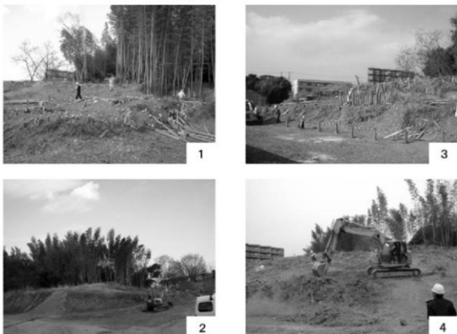
第77図 保存整備工事その1 前方部の竹木伐採除根工作業風景
