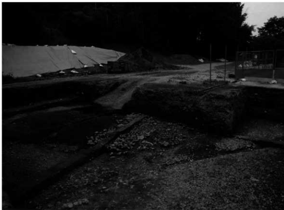
(3) 11-1区 東造り出し周辺の礎の検出状況 (南東から)
