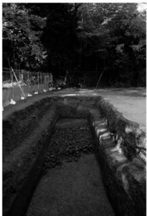
(1) 11-5区 前部東側掘部の転落石検出状況(東から)
