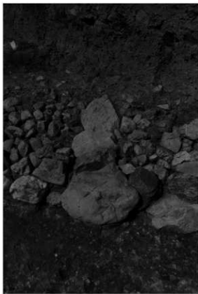
(2) 4-2区 前方部南側裾部の葺石 (南東から)
