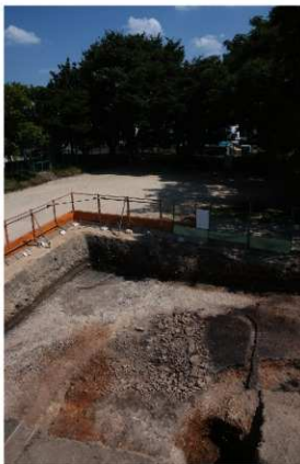
8. 第1区全景 (北西から)
