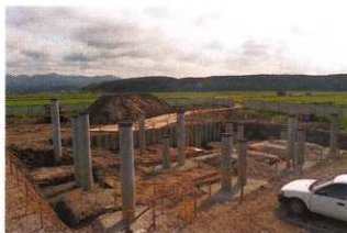
6. 調査前風景 (西から)
