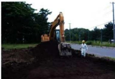
写真1 重機による表土除去状況
