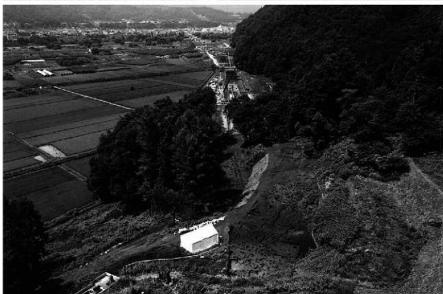
調査地全景 (南より)
