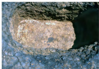
SK715 坑底ビット 横出状況
