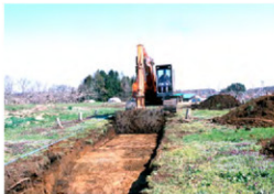
重機トレンチ作業
