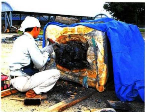
平成11年6月初旬に保管のための、硬化作業が終了したため鉛の取り出しを実施しました。
