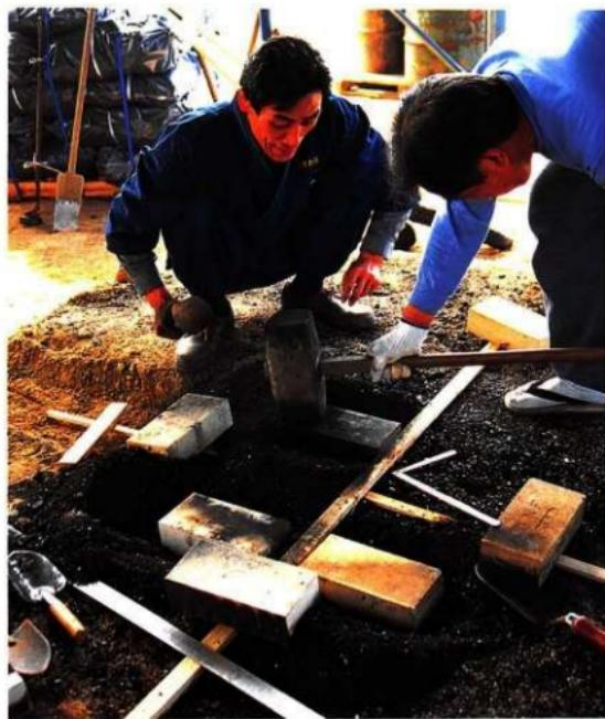
鍛炉／下灰が終了した炉床に、下灰の中央となる部分を正確に測り基を焼く。
