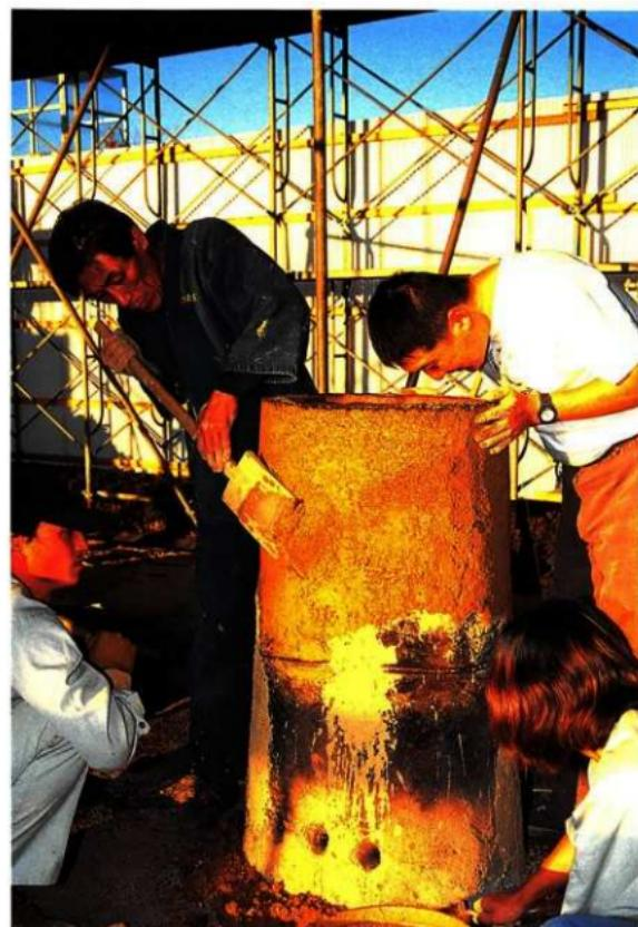
築炉／「釜がえ」を使い余分な粘土を取り除く。
