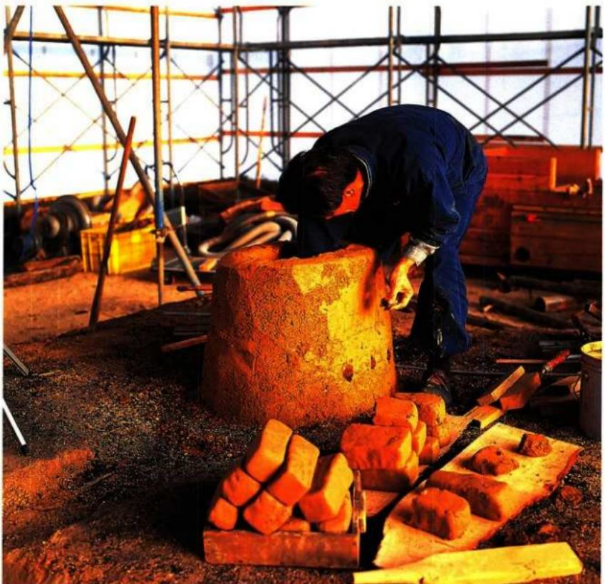
荒炉／下釜ができると中釜まで一気に作り上げる。(1号炉)
