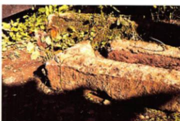
写真② 轰泉水道に使用されていた凝灰岩製の石樋
