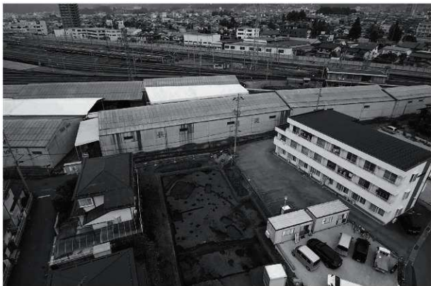
調査地遠景（東より）
