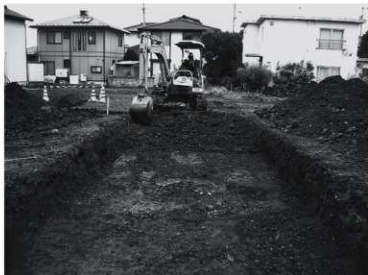
重機掘削状況
