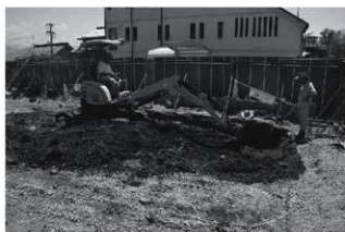
重機掘削作業
