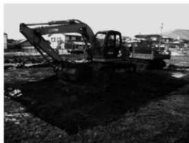
重機によるA区表土剥ぎ（平成24年3月1日）
