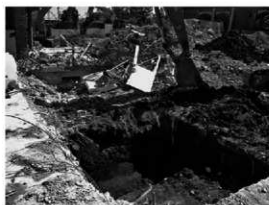
旧校舎の試掘調査（平成25年6月3日）
