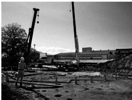
調査区画で稼働する大型建設機械（2012年5月22日）
