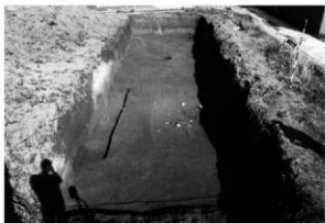
92-③区 (東) 2次面全景 (北から)
