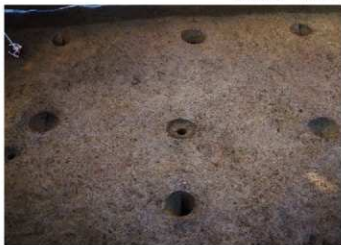
3号掘立柱建物跡 完掘（南から）
