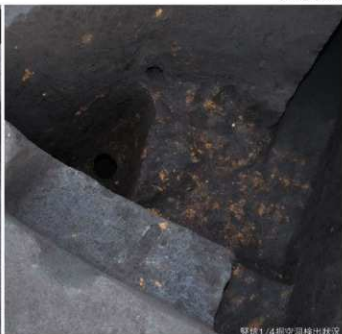
壁槽14棺空洞様出状況
