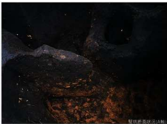
壁状断面状況(A軸)
