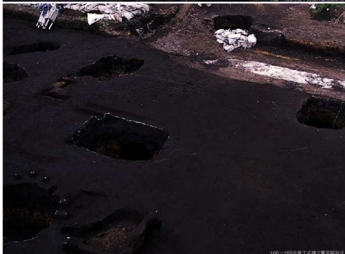
166--168号地下室桩孔基础现状
