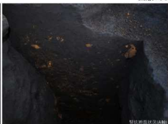
壁状断面状況(A軸)
