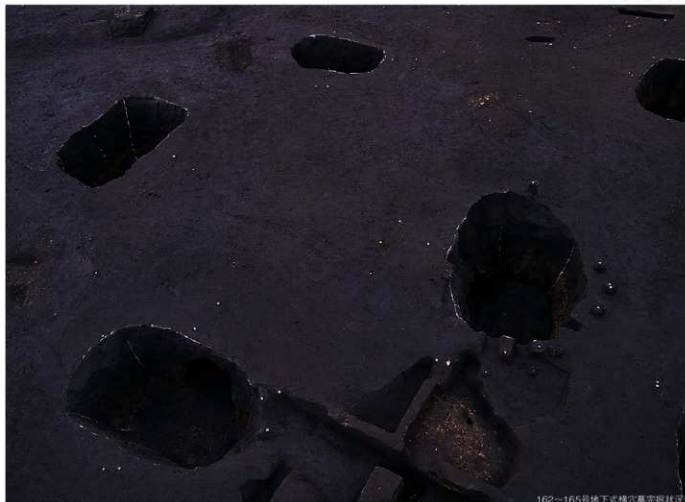
162--165号地下室桩孔基础现状
