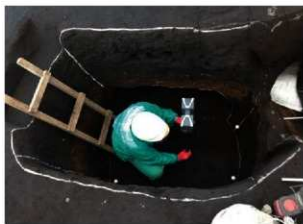
写真 計測機械設置の様子
