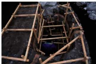
(2)ポリエステル樹脂積層・(3)角材補強
