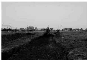
2号道路 表土の除去
