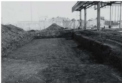
不明遺構 (SX-1) 検出状況
