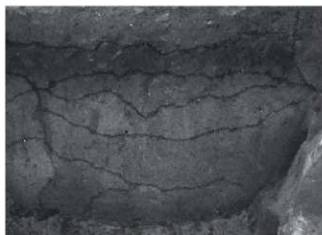
1 SK67セクション (北から)
