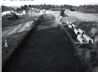
4 確認状況2 (南から)
