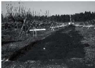
7 表土掘削状況1
