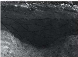
4 同 セクション2 (東から)
