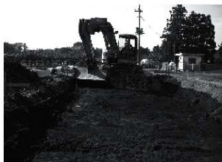
1 表土除去状況
