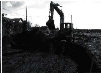
5 表土掘削状況（西から）
