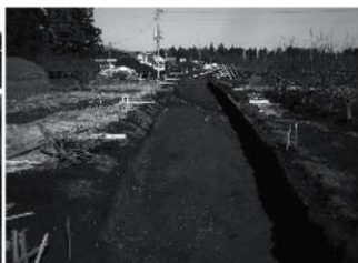
2 確認状況全景4 (南から)
