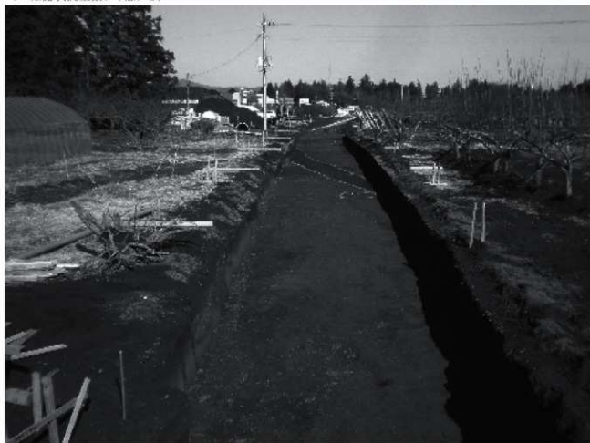
2 確認状況全景2 (南から)
