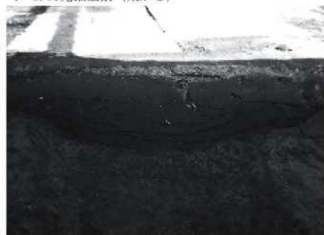
2 同 セクション1 (南から)
