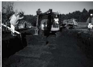
8 表土掘削状況2
