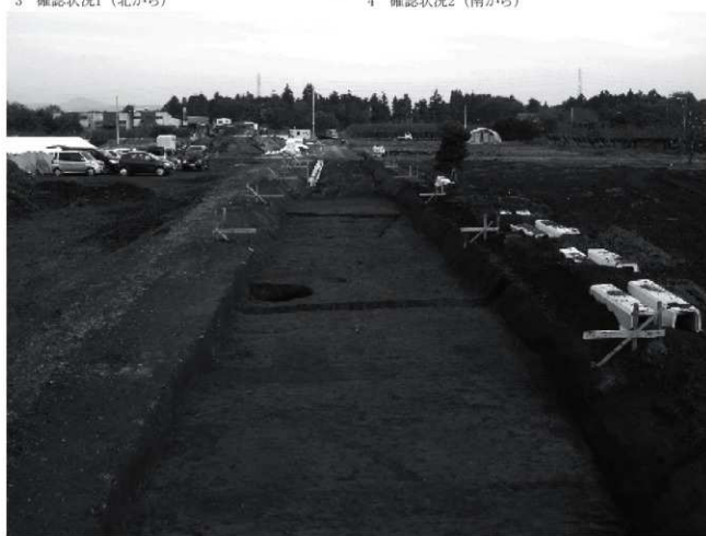
5 調査終了状況 (南から)
