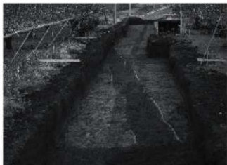
1 確認全景1 (西から)
