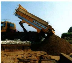
Pl.170 埋め戻し作業状況写真③
