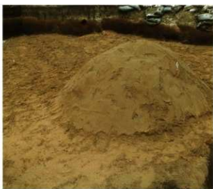
Pl.179 埋め戻し作業状況写真⑫
