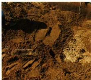
Pl.173 埋め戻し作業状況写真⑥
