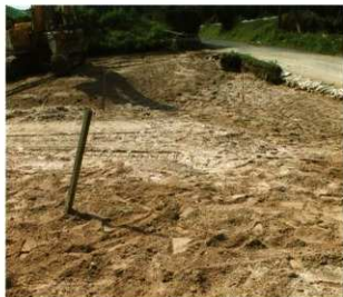
PI.181 埋め戻し作業状況写真⑭
