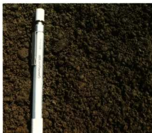
PI.185 埋め戻し作業状況写真⑱
