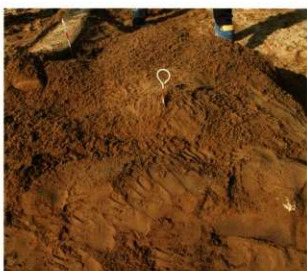
Pl.177 埋め戻し作業状況写真⑩
