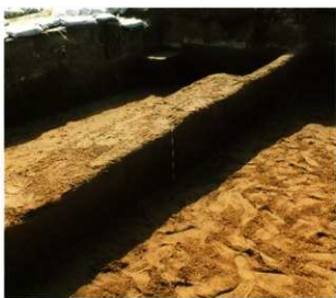
Pl.178 埋め戻し作業状況写真⑪
