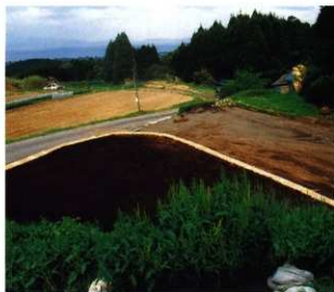
Pl.169 埋め戻し作業状況写真②
