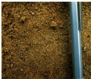
PI.183 埋め戻し作業状況写真⑯
