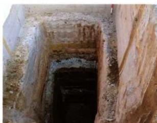
Pl.7 12トレンチ北壁層位断面(三段目)状況写真②
