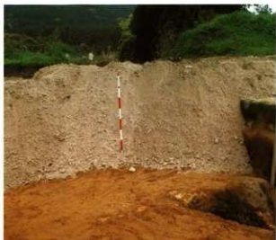
PI.180 埋め戻し作業状況写真⑬
