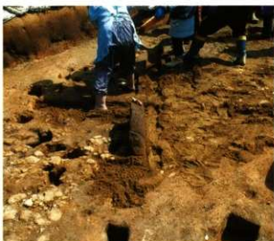
Pl.172 埋め戻し作業状況写真⑤
