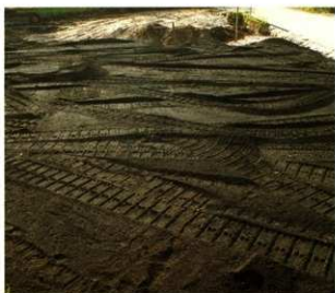
PI.182 埋め戻し作業状況写真⑮
