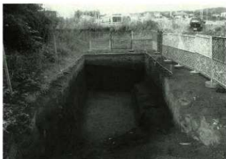
写真16 3トレンチ全景
