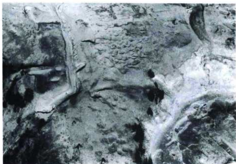
7号中世区画 (南側上空から)
