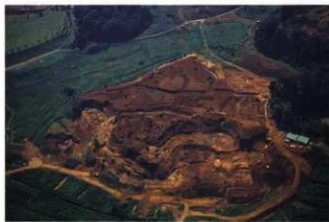
写真138 城山遺跡全景（東側から）
