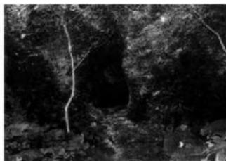
の前には爆風除けの石積みが見られ、進入路は鋭型に屈曲させているのが解る。特に崩落、改変等は見られず、現状は極めて良好である。
