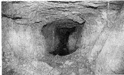
壕口には水没している場所がある
