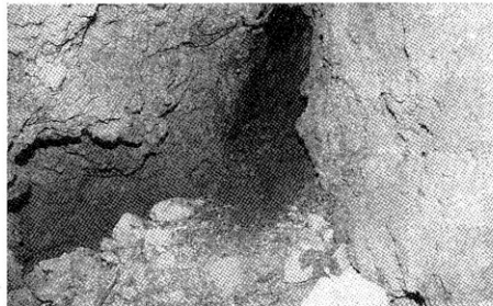
塚内の落盤跡
