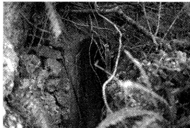
観測所と思われるコンクリート製構築物入り口
