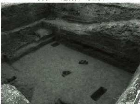
写真23 ビット完掘状況
