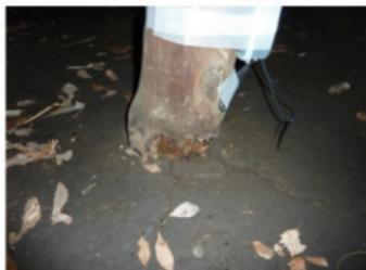
写真1 従来型の未処理土間面と腐朽が進行している柱材（復原建物2）
