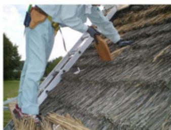
写真9 専用工具による差し茅
