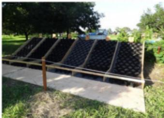
写真3 型枠敷設
