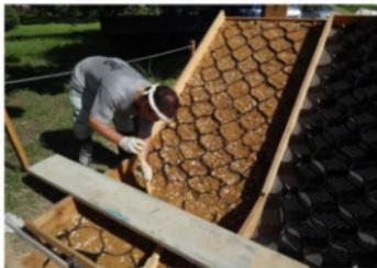
写真4 下層土転圧（工具転圧面Φ10cm）
