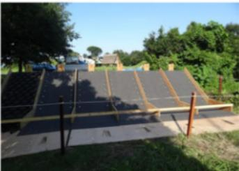
写真2 不織布・アンカーピン敷設
