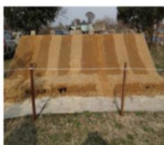
写真11 飛散防止剤散布後
