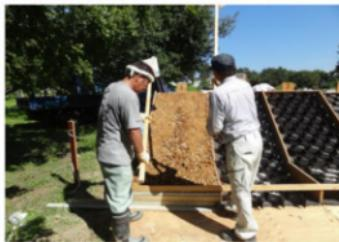
写真5 上層土転圧（工具転圧面30×20cm）
