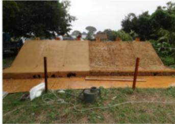
写真6 表層土仕上げ・上層土転圧後
