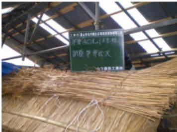
写真 267 屋根棟部 下地調整茅葺
