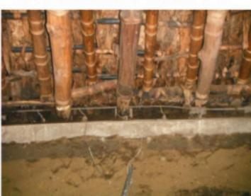
写真 162 腐朽部分除去後の杈首 16～18
