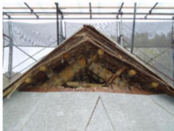
写真358 煙出し窓部分の細部構造
