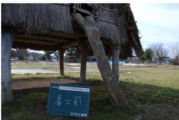
写真 234 梯子(旧材)の腐朽状態(平成23年度)
