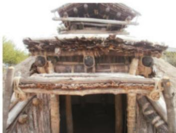
写真323 出入口梁上下の樹皮壁増設
