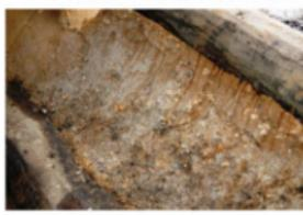
写真 336 凍害による剥離 (2/2)
