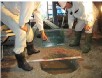
写真 221 土間下地の不陸調整と炉穴掘削
