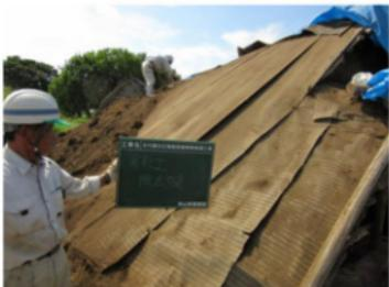
写真 198 防水シート露出作業
