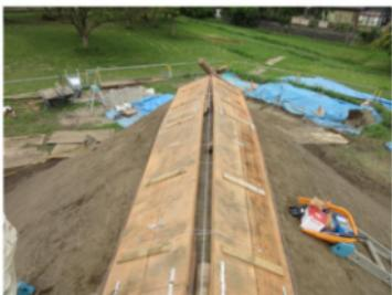
写真 218 樹皮屋根下地の高さ調整
