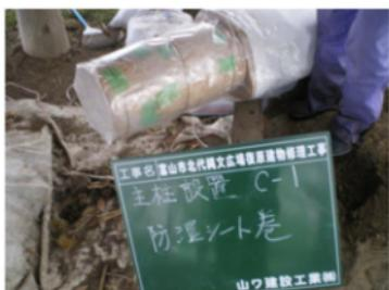
写真 251 新規調達主柱6防水・防湿シート巻付
