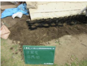
写真 210 型枠敷設
