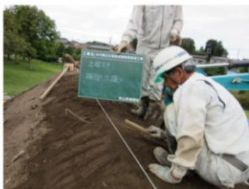
写真 213 棟部水平確認と樹皮屋根固定用番線出し
