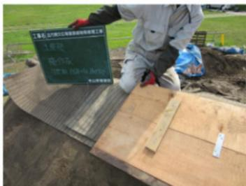
写真 216 樹皮屋根下地の下部構造
