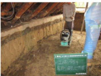
写真 164 土間掘削終了後の機械転圧
