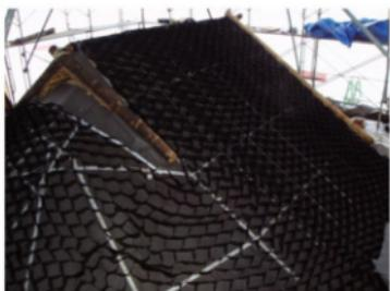
写真360 防水シート・不織布・フラットバー・型枠敷設
