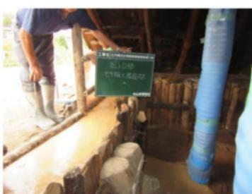
写真 225 出入口のタタキと丸太刻み梯子の設置
