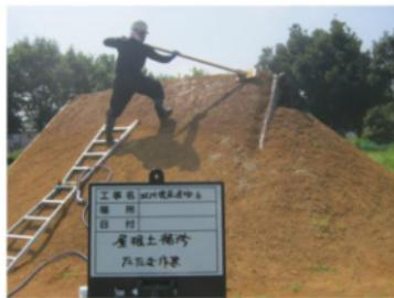
写真376 亀裂の補修と増締め(2)
