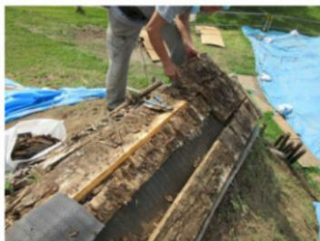
写真192 樹皮屋根解体(1)
