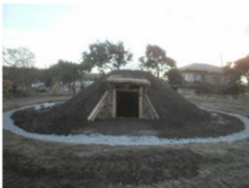
写真313 屋根土葺の完成と周辺の整地
