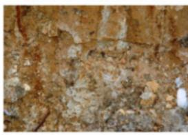
写真 335 凍害による剥離 (2/3)
