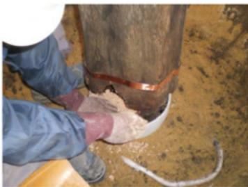
写真 255 ガソリン塗布後の目地埋め、銅板巻付
