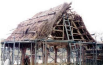
写真232 整備段階の茅葺過程
