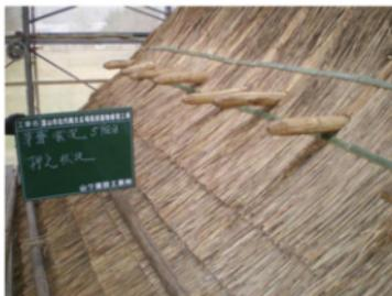
写真 265 屋根上部 段葺状態
