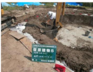
写真 290 セメント改良土機械転圧・人力調整
