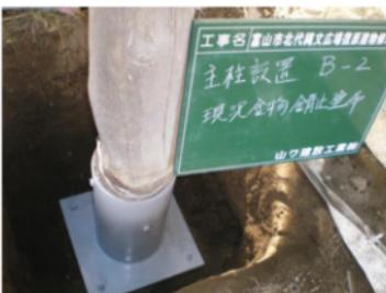
写真 252 継続使用主柱 柱脚金具防錆剤塗布
