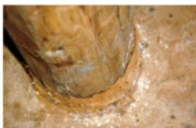
写真 344 主柱ゼオプレース上端の反り (2/22)
