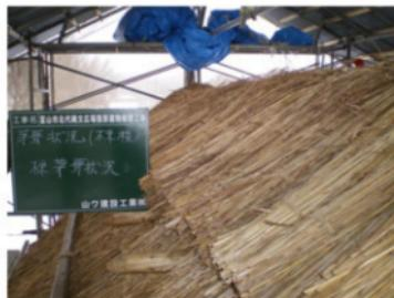
写真 266 屋根棟部 下地茅葺 (折曲) 状態
