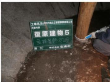
写真305 粘土補強と主柱基部コーキング処理
