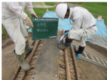
写真 220 樹皮屋根の傘釘コーティング処理
