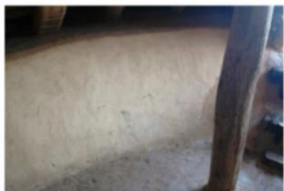
写真 340 出入口付近の水染み (2/22)
