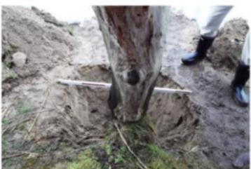
写真 236 梯子裏側の腐朽・虫害状態
