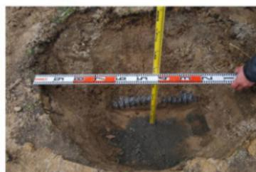
写真 239 基礎碎石(RC40、最大厚16cm)と透水管
