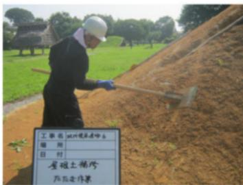
写真375 亀裂の補修と増締め(1)
