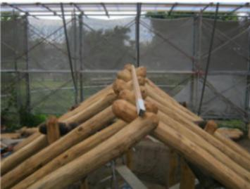
写真353 棟部分の水平確認
