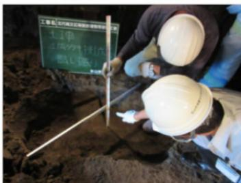
写真153 既存土間掘削前試掘（FL-20cm）
