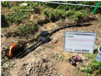
写真351 機械換気設備除却後の電気配線
