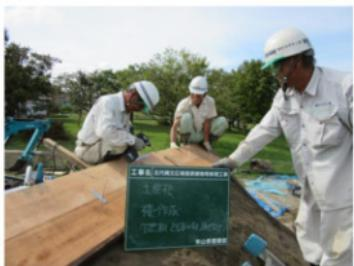
写真 217 樹皮屋根下地板敷設
