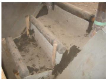
写真362 土階段側面への木毛セメント板敷設
