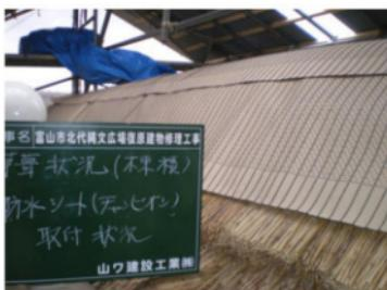
写真 269 防水シート (ウルトラチャンピ' オン) 敷設
