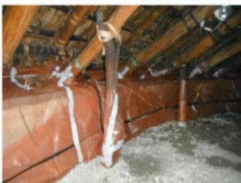
写真180 桁首尻支持柱設置状態(1)
