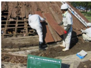
写真 206 小舞取替・樹皮葺替作業
