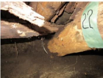
写真 161 腐朽部分除去後の杈首 22
