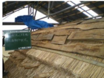
写真 268 屋根棟部 下地板 (既存材) 取付
