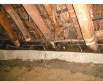
写真 163 腐朽部分除去後の杈首 18～21
