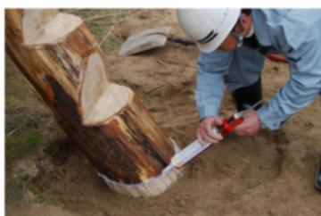
写真 241 カルトナッヒ" オン上端部防水措置
