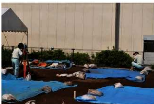
測量杭打ち作業
