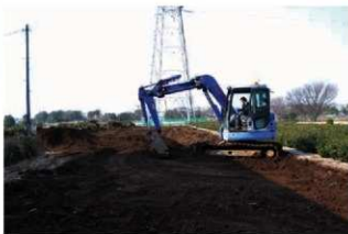
重機表土剥ぎ
