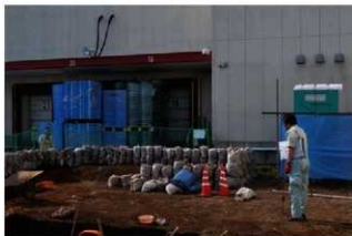
測量杭打ち作業
