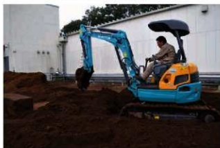
重機埋め戻し
