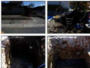
写真 調査状況
