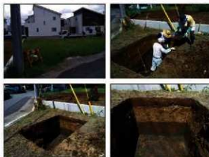
写真 調査状況
