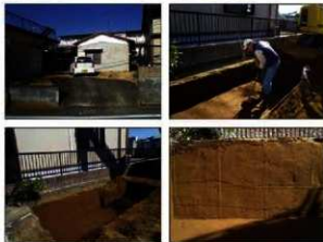
写真 調査状況
