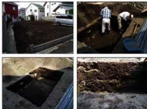
写真 調査状況
