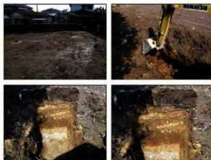
写真 調査状況
