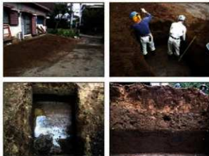
写真 調査状況
