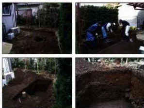
写真 調査状況
