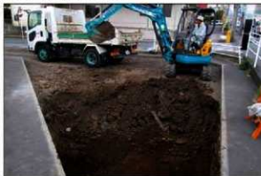
写真 調査状況
