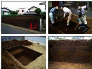
写真 調査状況
