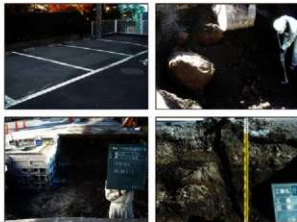
写真 調査状況
