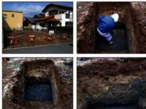
写真 調査状況
