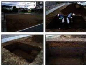
写真 調査状況
