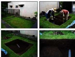
写真 調査状況
