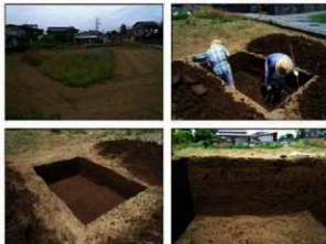
写真 調査状況
