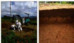
写真 調査状況
