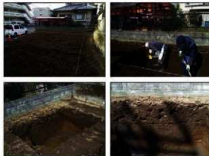
写真 調査状況
