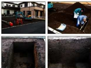
写真 調査状況
