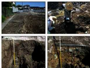
写真 調査状況
