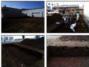
写真 調査状況
