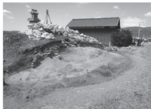
写真3-18 墳丘北側の盛土検出状況
