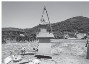
写真3-1 バックホウによる既存祠の撤去
