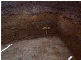
9. 硬化面の状況
