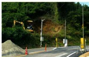
工事立会い状況
