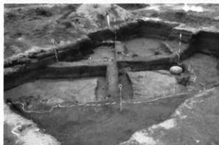
1 平地式建物調査状況
