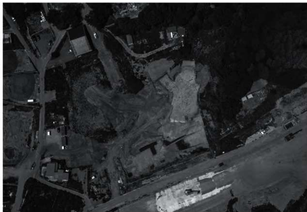
A区全景(直上→)
