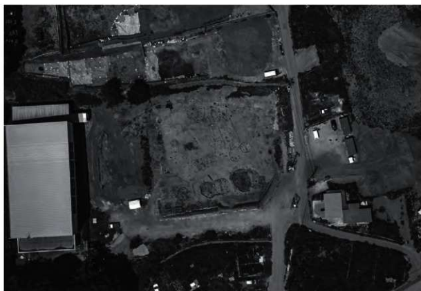
B区全景(直上→)
