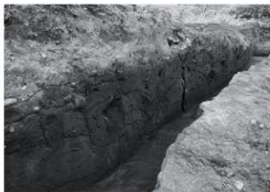
北壁トレンチ断面 (東側)
