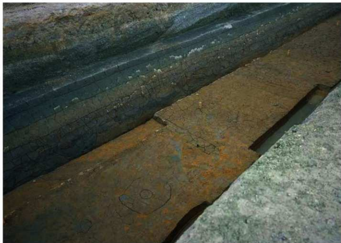
写真 24 01SD (06SF 東側溝) と 07SA -北東から-
