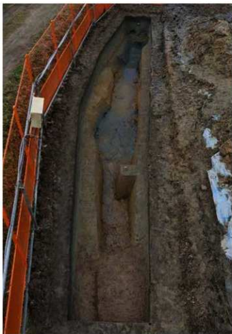
写真 37 3区全景 遺構完掘状況 -北東から-
