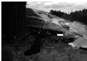
平成27年度表土除去作業1
