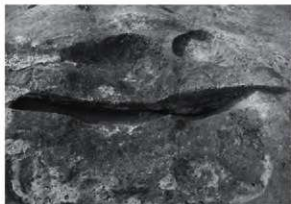
下部構造断面（南東から）
