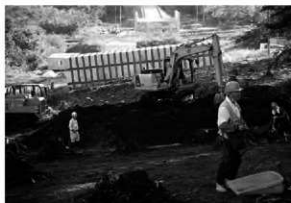
平成28年度重機稼働状況
