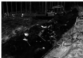
平成27年度表土除去作業2
