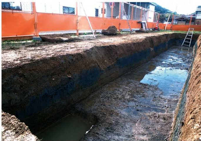
写真 50 調査区南壁 土層断面 - 北東から -
