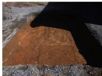
写真43 調査区全景（西から）
