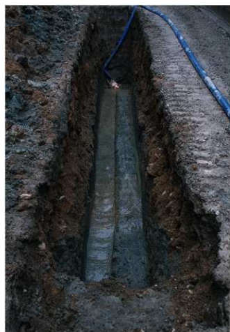
写真45 調査区全景 -西から-
