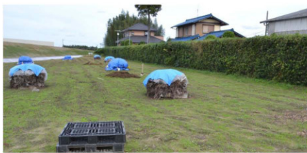
三反田遺跡の脇を通る建設中のいち子連絡道
