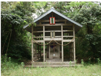
覆屋の掛った本殿
