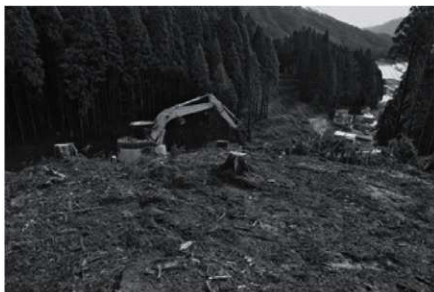
作業状況(6区) 西から
