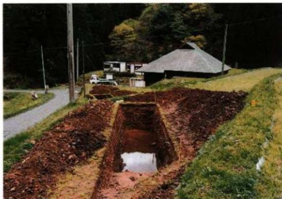
第3トレンチの掘り下げ状況で地山崖面からの湧水のため、水中ポンプを使用したが発掘中止した。地山は基盤が崩れた崖錐性堆積物であった。
