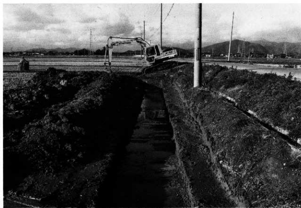
神照寺坊遺跡調査風景
