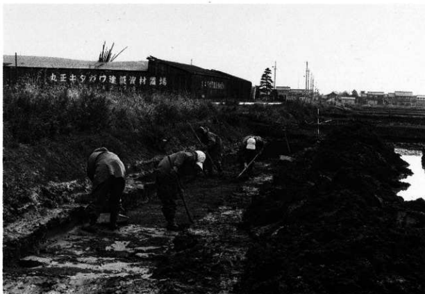
地藏遺跡調査風景
