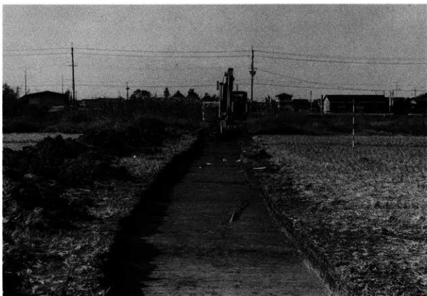
東側トレンチ掘削風景
