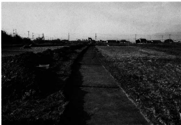
東側トレンチ掘削風景
