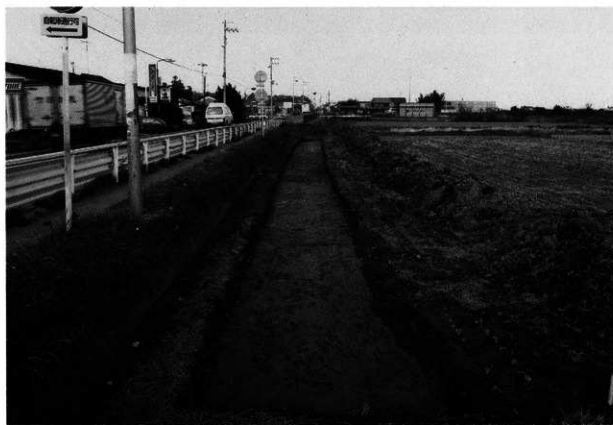
西側第2トレンチ調査後風景（南より）
