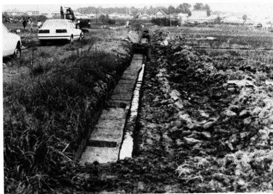
第2トレンチ南部(南より)
