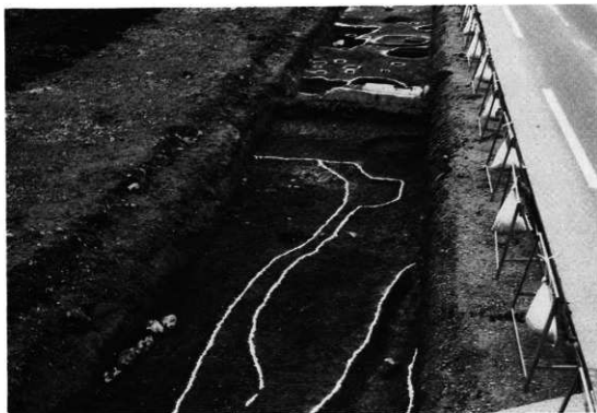
第25トレンチ西半部（西より）
