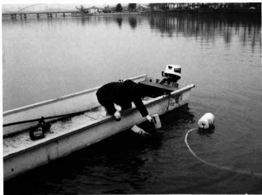
南湖航路浚渫 作業状況
